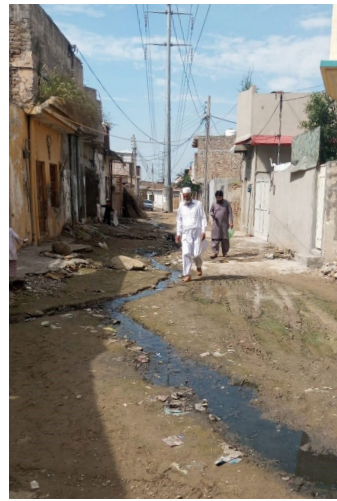
Offene Kanalisation in einem Dorf
