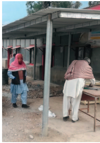
Das Vordach für die Behelfsklinik in Balakot ist fertig
