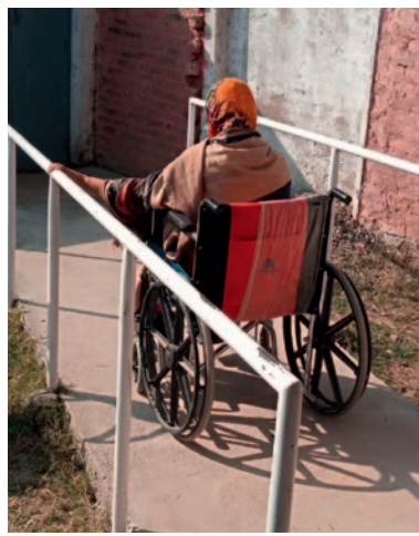
Neu gebaute Rampe als Zugang für Rollstuhlfahrer zum Gesundheitsposten
