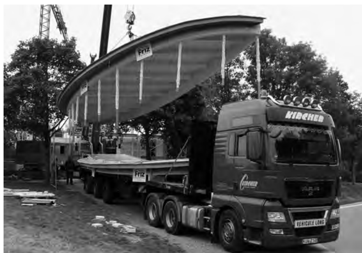
Schwertransport der zwei Dachhälften
