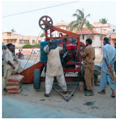
Während der Bauarbeiten
