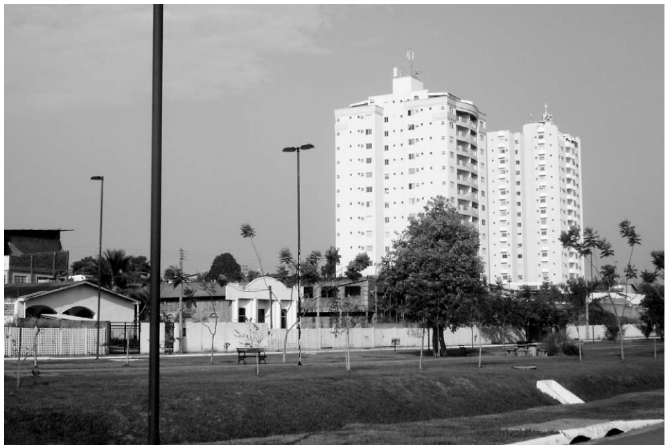
Straße mit Hochhäusern
